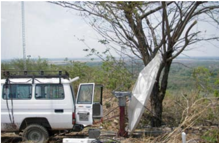
شكل 11.34: تركيب الهوائي في إل باول.
