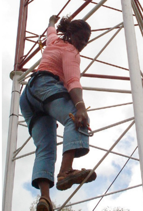
شكل 11.3: لا تخشى أومولايو صمونيل Omolayo Samuel أحد موظفي Zittnet إرتفاع برج الإرسال (45 متراً) أثناء قيامها بتوجيه الهوائيات المركبة أعلاه.
