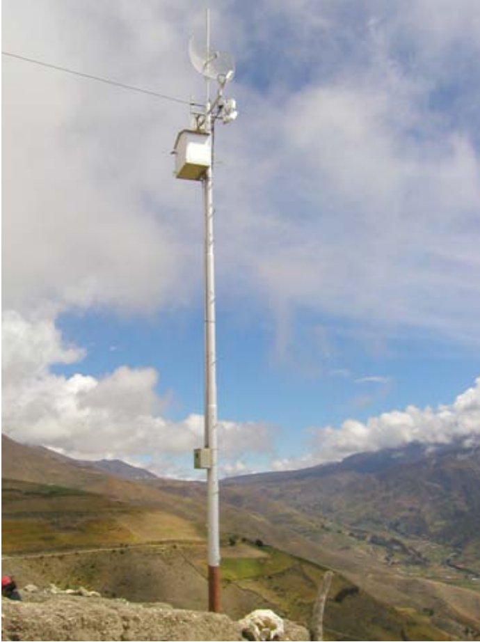
شكل 8.3: أحد الأشكال البسيطة للأبراج المدعومة ذاتياً.
